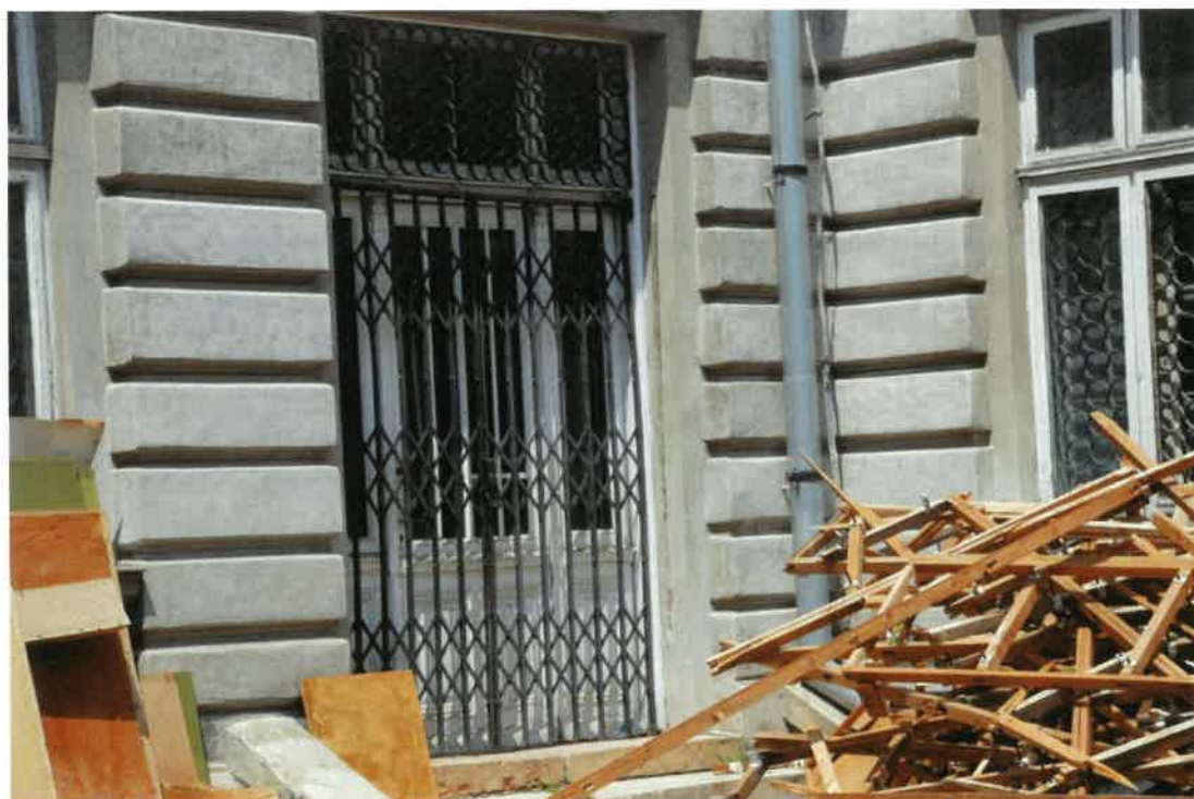
Grilaj ușă acces, montat la exterior
