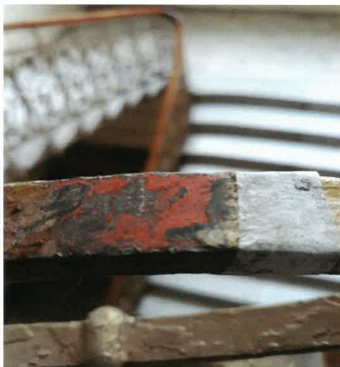
Imagine aspect după finalizarea tratamentului mecanic
