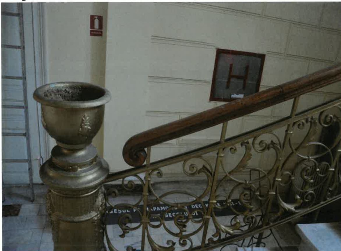
b. Imagine balustradă hol central, detaliu decor și mână curentă din material lemnos, către etaj
